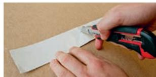
1. Breites Haftpapier auf der Klebestreifenrückseite mittig einschneiden
