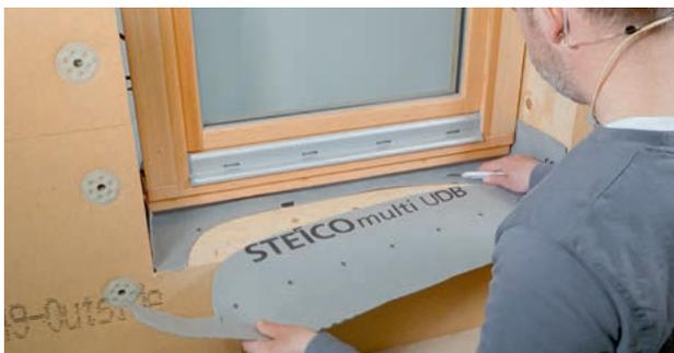
2 Der Einbau erfolgt auf der Unterdeckbahn. Vor der Montage von STEICOfix 2.0 wird die Bahn „halbmondförmig“ zurückgeschnitten (vgl. Bild 5).
