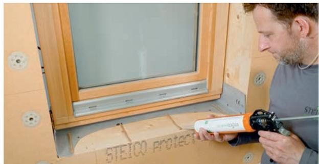
5 Als Abhebesicherung des Dämmkeils werden STEICOmulti fill Kleberaunen angebracht, e  $\leq$  30 cm.
