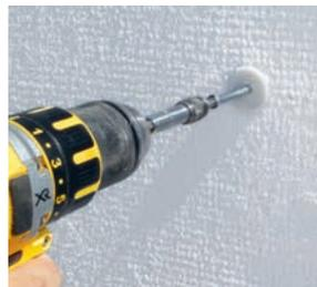
Leichte Lasten wie Außenlampen oder Briefkästen können allgemein in alle genannten Platten aus STEICO WDVS Timber mit Dämmstoffdübeln wie der STEICO Montagespirale in STEICO Putzträgerplatten befestigt werden. Das Loch für die Montagespirale muss mit einem Holzbohrer mit 8 mm Durchmesser vorgebohrt werden.
