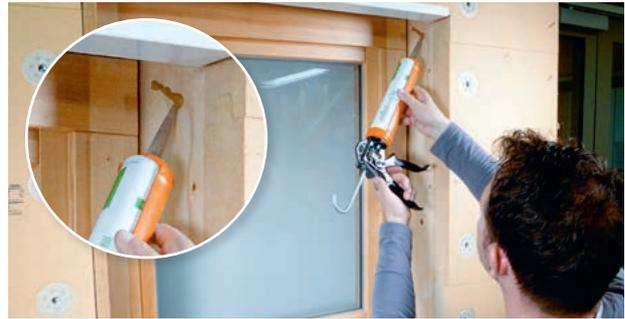
10 Aufbringen von STEICOmulti fill Kleberaupen in die Holzrahmen-Konstruktion, um einen sicheren Halt der Laibungsplatte zu gewährleisten.
