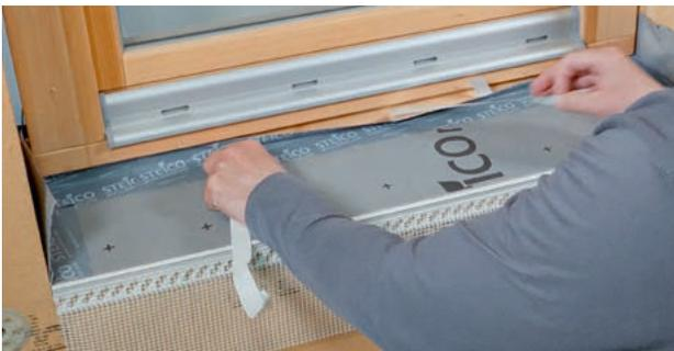
7 Einsetzen des STEICOfix 2.0 auf die Brüstung, restliches Abziehen des Klebeband-Trennpapiers und Andrücken des STEICOmulti tape F Klebebandes.
