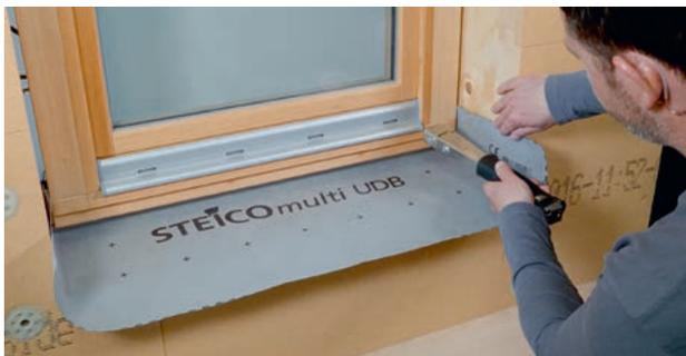
1 Anbringen von STEICOmulti UDB (diffusionsoffene Unterdeckbahn) als temporärer Witterungsschutz bis zum Einbau.
