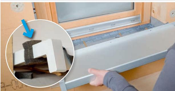
9 Einbau der Fensterbank. Die hintere Blechverfaltung befindet sich in der passenden Fensterrille, die vordere hat einen Abstand von  $\geq 3$  cm zur Putzfassade. **TIPP:** Kompribänder in der Kühlbox aufbewahren. Das verhindert eine zu schnelle Ausdehnung.
