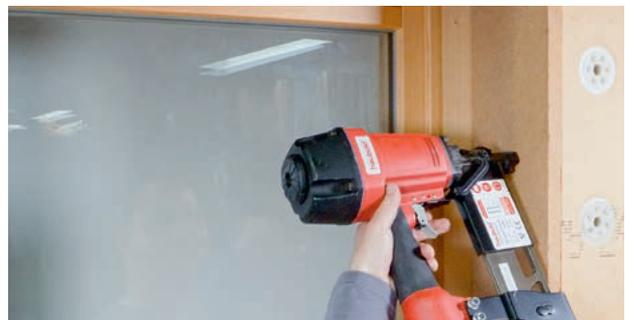
12 Fixierung der Laibungsplatte als Pressdruck zur ungestörten Aushärtung von STEICOmulti fill mittels Edelstahl-Breitrückenklemmern oder Edelstahlschrauben.
