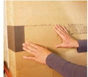
Bei mittelschweren Lasten ist eine Druckverteilung auf dem WDV-System durch Montagequader nötig. Beispiele hierfür: Kleiderbügelhalter, Rohrschellen, Werbetafeln, Rückhalter, Vorreiber von Fensterläden. Der Einbau erfolgt kraftschlüssig, flächeneben in der Dämmebene der Holzfaser-Dämmplatte.
