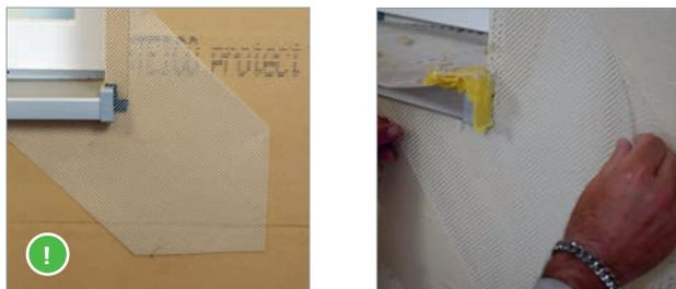
Die Diagonalarmierung wird in Öffnungsbereichen direkt nach der Montage der Gewebe-Eckwinkel (nass in Nass) ebenfalls mit Armierungsmasse eingespachtelt. Die Geometrie des Armierungsstreifens ist so ausgerichtet, dass er pfeilförmig diagonal in allen Ecken angebracht werden kann.
