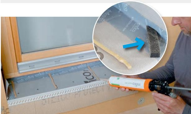
8 Auftragen von STEICOmulti fill Kleberaupen  $e \leq 30$  cm für die elastische Befestigung der Fensterbank. **TIPP:** Schräg aufgeklebte Kompribänder leiten evtl. eintretende Nässe sicher zur Tropfkante
