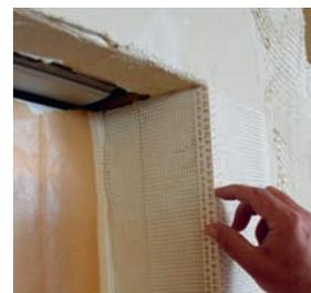
Der STEICOsecure Base Armierungsmörtel wird an Außenecken von Wänden und Laibungen aufgetragen und anschließend der Gewebeeckwinkel eingespachtelt.
