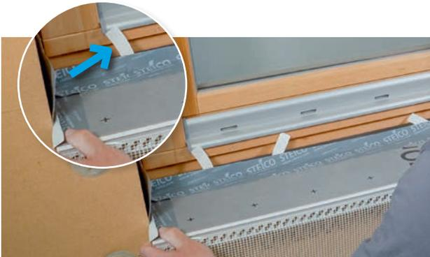
6 Einbau des STEICOfix 2.0 Dämmkeils. **TIPP:** Trennpapier zurückfalten, es kann später leichter entfernt werden.
