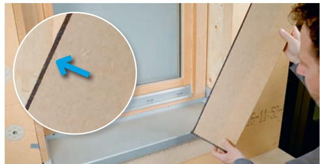
11 Einsetzen der Laibungsplatte 20 mm bündig zur Außenkante der WDVS-Fassade; Schlagregenschutz durch Anbringung von Fugendichtbändern an der Hinter- und Stirnkante. **TIPP:** Ggf. Fensterstockverbreiterung einplanen.
