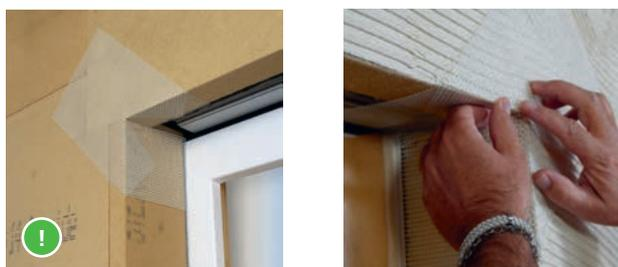
Im Bereich des Fenstersturzes bieten die Sturzeckwinkel eine Möglichkeit, um auch in der Innenecke der Laibung eine ausreichende Armierung sicherzustellen.
