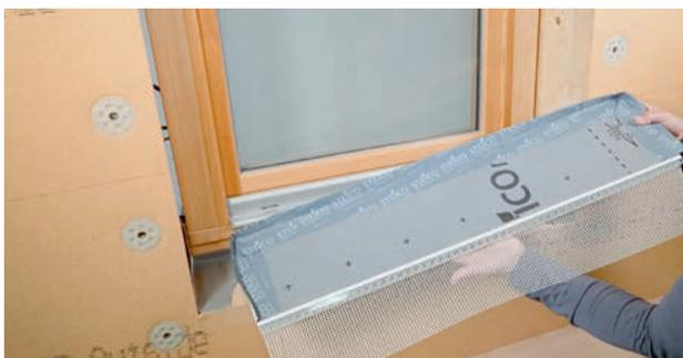
3 Im Anschluss werden die STEICOmulti tape F Klebestreifen so auf dem Dämmkeil angebracht, dass eine „dreiseitige Wanne“ ausgebildet wird.
